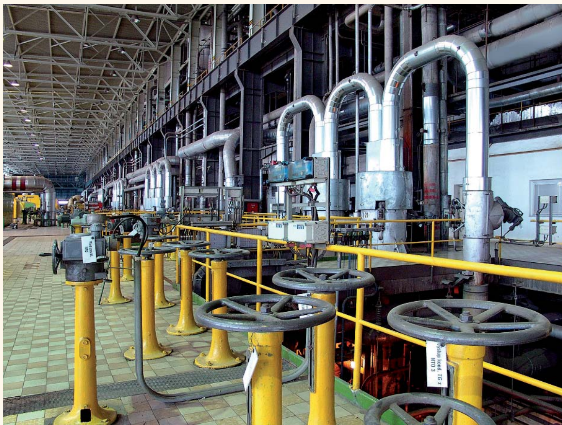
Strojovna / Turbine Hall
