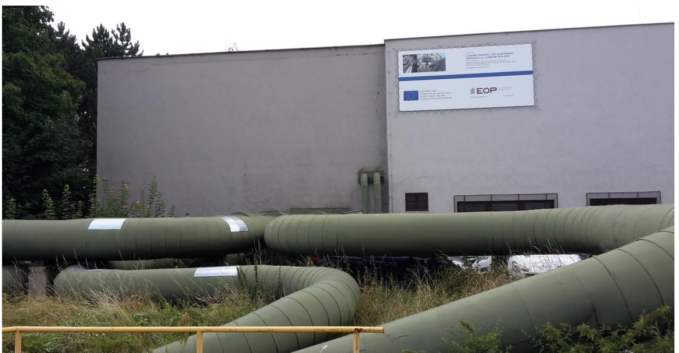
obr. 2 Budova DT Sever
