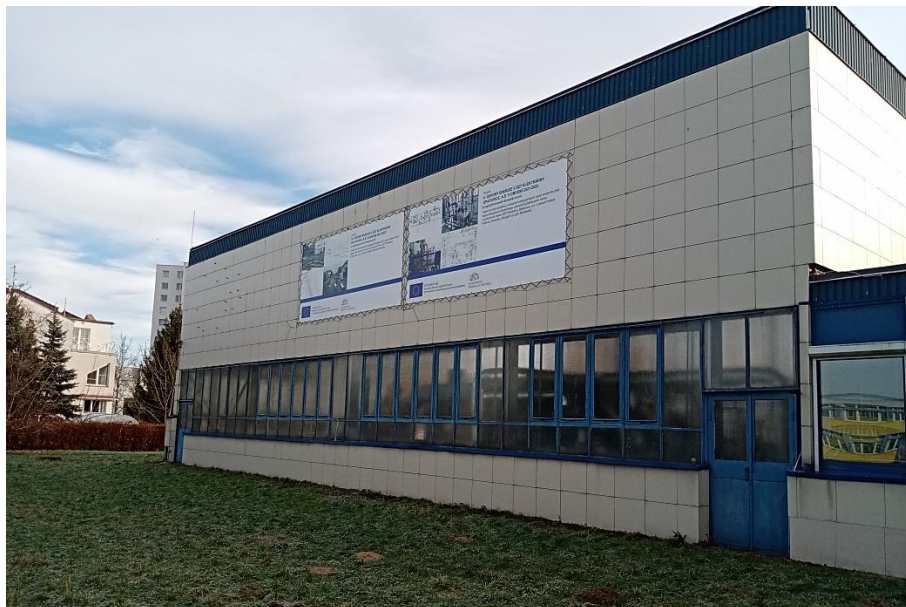
Obr.: Budova DT JIH v Pardubicích
