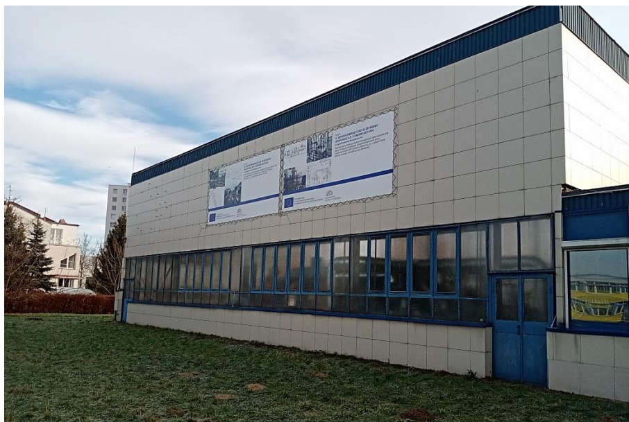
Obr.: Budova DT JIH v Pardubicích
