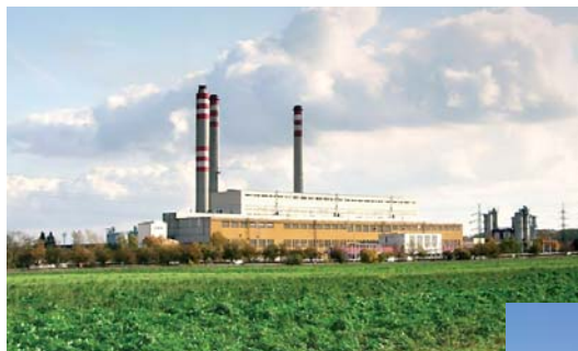
Elektrárna Opatovice / Opatovice Power Plant
